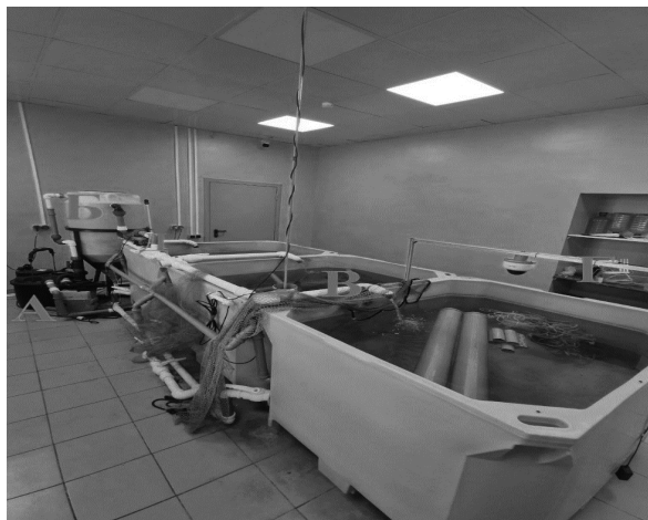
Рис. 3. Работающая система УЗВ для содержания ракообразных (А — напорный фильтр механической очистки воды, Б — фильтр биологической очистки воды, В — изотермические емкости для содержания ракообразных, Г — камера видеофиксации активности и поведения маточного стада креветки, Д — комплекс ультрафиолетового обеззараживания воды) (фото авторов)
